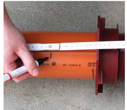
Verlängerungsrohr rechtwinklig abschneiden und in Schalung einbauen.
