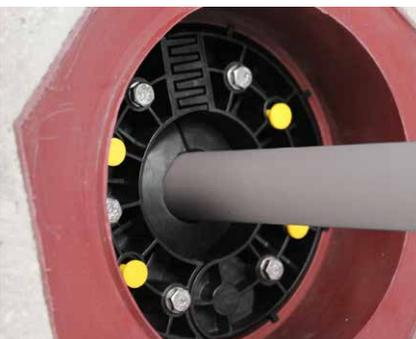
Bei Dichtelementen mit Verpressindikatoren werden zunächst die Schrauben locker über Kreuz angezogen, bis die Verpressindikatoren aus dem Flansch gedrückt werden (mindestens 1 mm).
