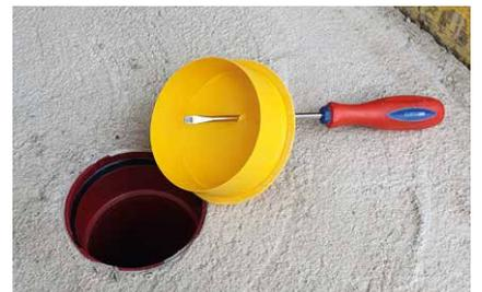
Dichtelement aufklappen. Zwiebelringe nach Erfordernis herausziehen, anschneiden und abreißen.
