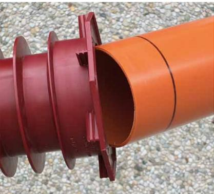
Verlängerungsrohr mit glattem Ende in das Lamellenrohr einstecken.
