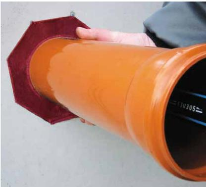
Setzungsschutzrohr in das Lamellenrohr einstecken.
