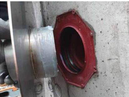
Flämmflansch mit Gleitmittel bestreichen und bis zum Anschlag einschieben.
