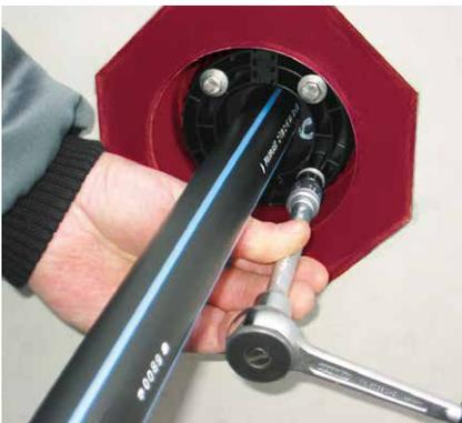
Schrauben in mehreren Durchgängen über Kreuz anziehen.
