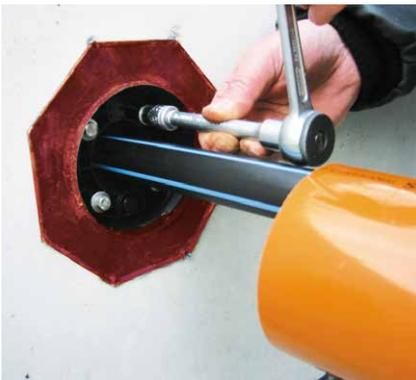
Schrauben in mehreren Durchgängen über Kreuz anziehen. Anzugsmoment 6 Nm.
