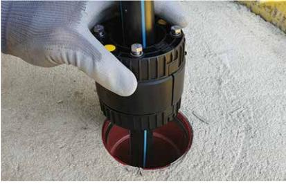
Dichtelement über die Mediumleitung klappen und bis zur Anschlagkante in die Bodendurchführung schieben.
