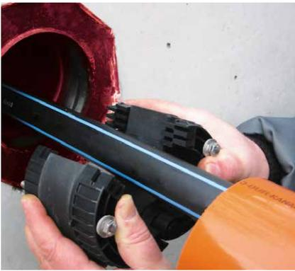
Dichtelement über das Mediumrohr klappen und bis zum Anschlag in das Lamellenrohr einstecken.
