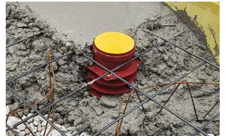
Bauschutzdeckel entfernen - Mediumleitung durch die einbetonierte Bodendurchführung einziehen.
