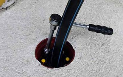
Schrauben in mehreren Durchgängen über Kreuz handfest anziehen. Anschließend die Schrauben mit Drehmomentschlüssel auf 6 Nm anziehen.
