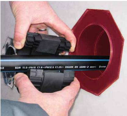
Dichtelement über das Mediumrohr klappen und in das Lamellenrohr bis zum Anschlag einschieben.
