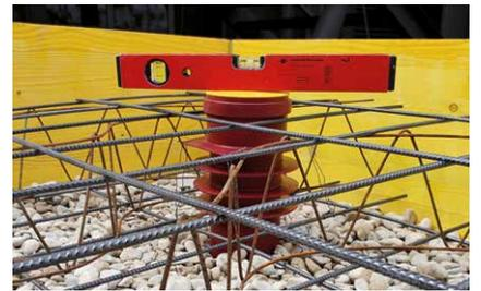
Bündig einbetonieren und mit Rüttler verdichten.
